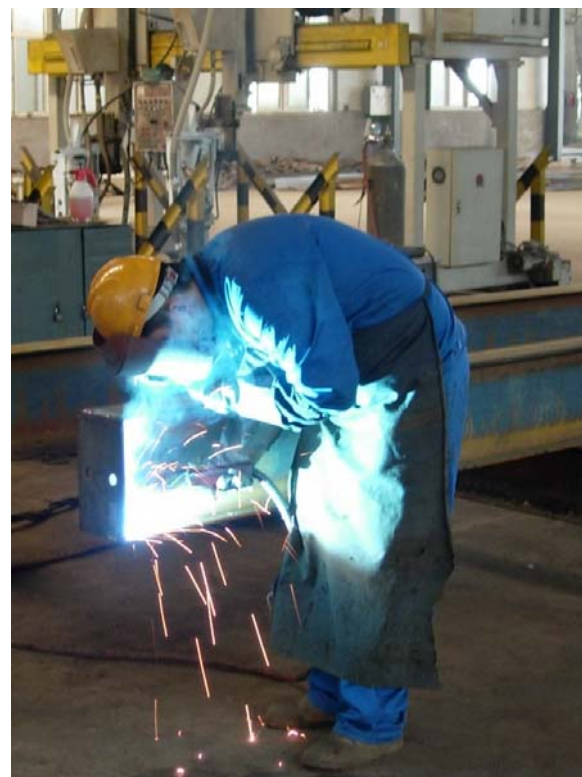
Soudure pour assemblage final
